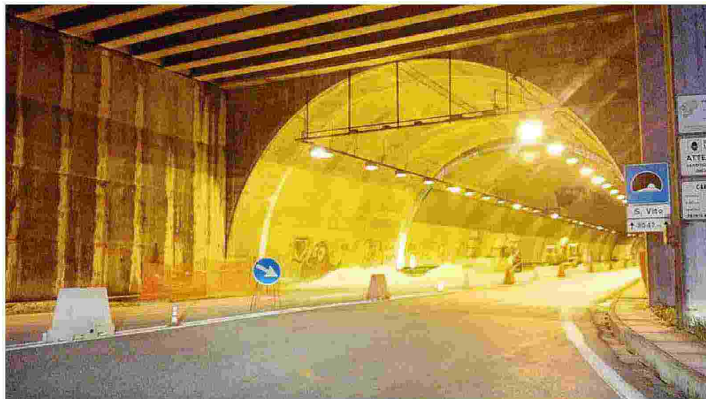
Il cantiere aperto nel corso del primo stralcio dei lavori nella galleria di Arsìe
