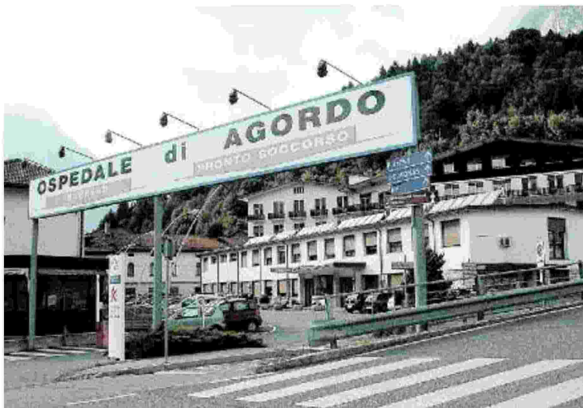
INGRESSO L'accesso all'ospedale di Agordo dove c'è anche la struttura residenziale per anziani
