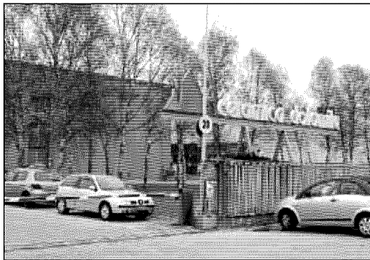
CAVASSICO INFERIORE Lo stabilimento di Trichiana
