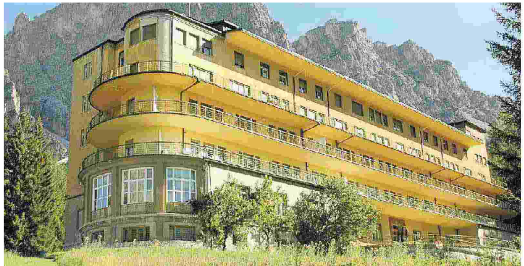
Il padiglione Putti del complesso ospedaliero di Cortina
