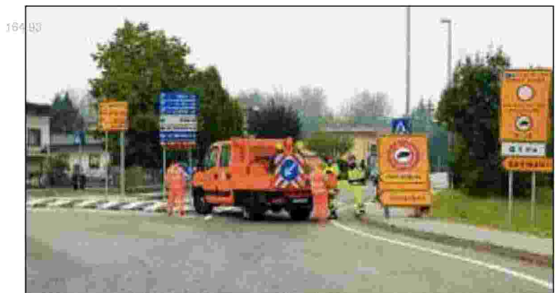
CANTIERE Operai di Veneto Strade impiegati in un lavoro a un incrocio stradale
