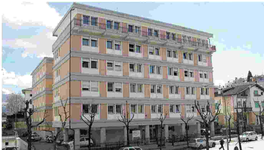
La sede amministrativa dell'Usl 1 Dolomiti in via Feltre a Belluno
