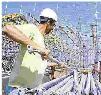
Un cantiere edile
