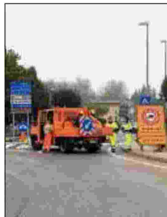
CANTIERE Operai al lavoro
