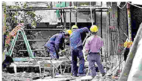
L'interno di un cantiere edile
