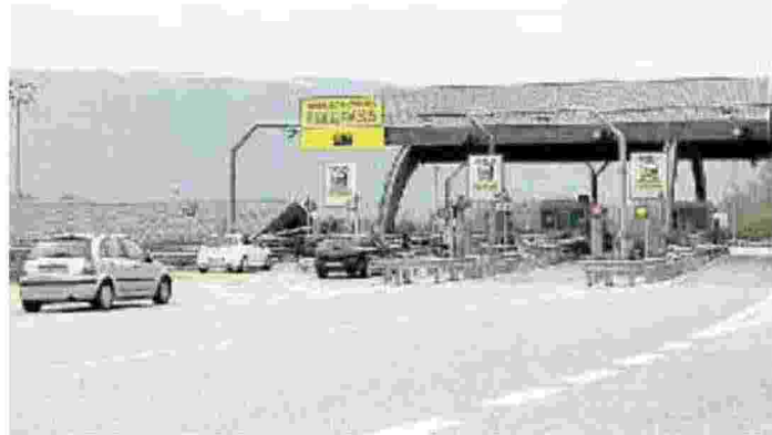
AUTOSTRADA A27 Gli imprenditori chiedono il prolungamento a nord
