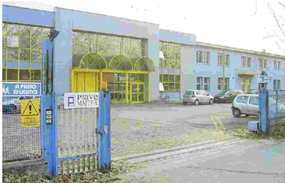
Lo stabilimento della Piave Maitex alla Peschiera
