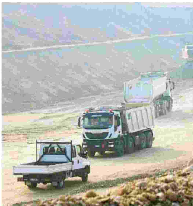
Un cantiere stradale
