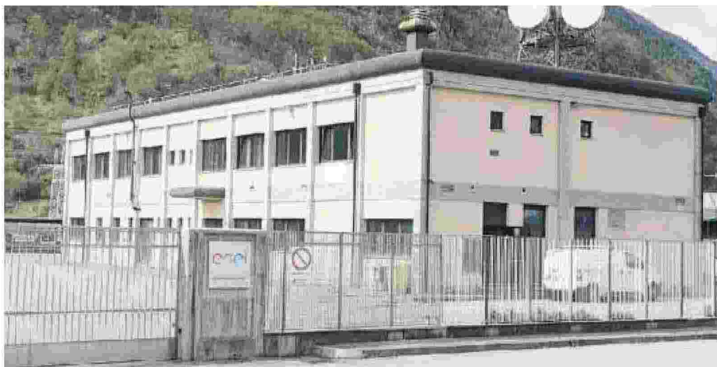
Il centro di controllo Enel di Polpet
