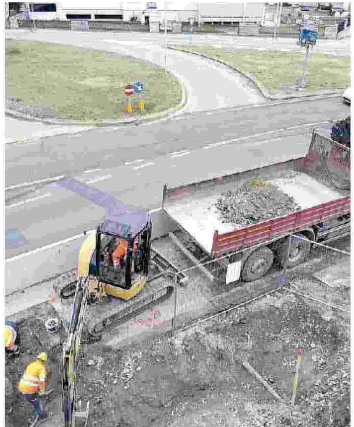
Un cantiere stradale
