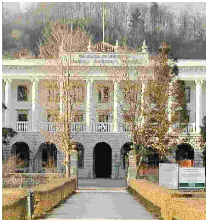
La casa di riposo Gaggia Lante
