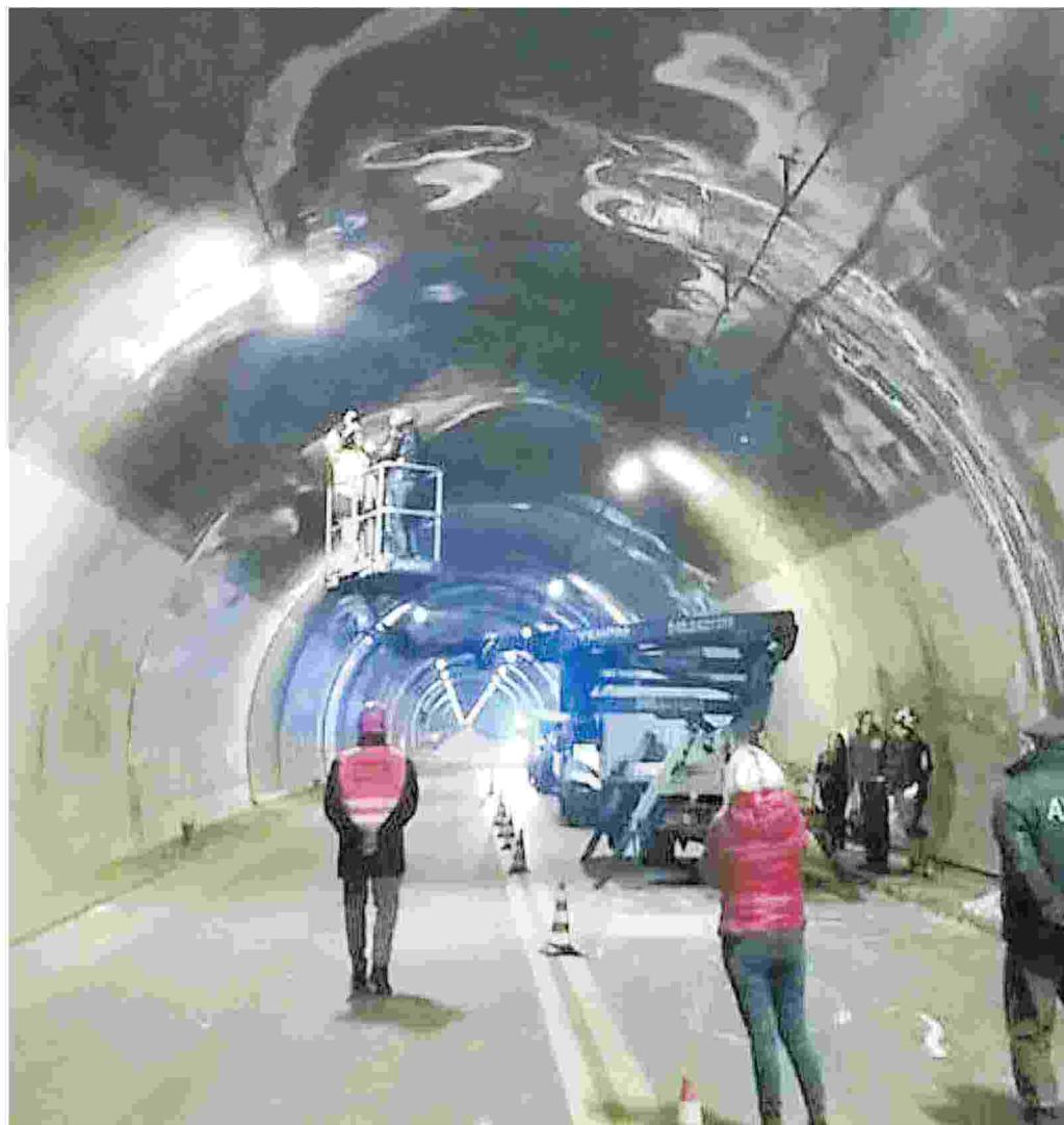
Un momento dei periodici lavori all'interno della galleria del Comelico
