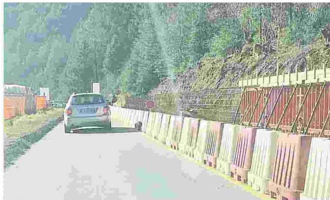
Un cantiere stradale sulle strade bellunesi
